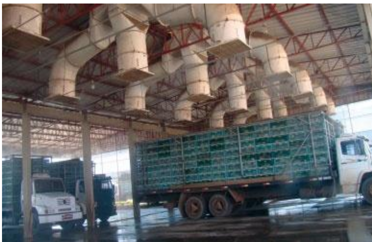
Image 56: Poultry lairage ventilation
